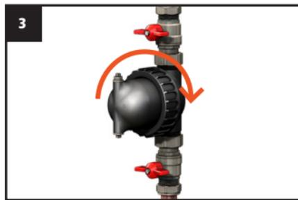
Introduire les joints de robinet et monter l'unité de filtrage à sa place, puis serrer les écrous des robinets d'isolement. Vérifier le bon serrage du collier du filtre. Vérifier que le purgeur d'air et le robinet de vidange sont bien fermés.
